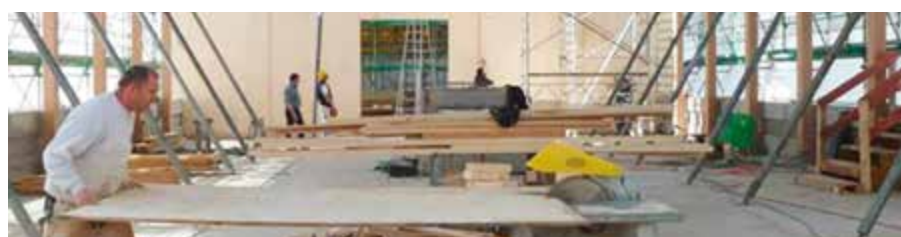
Neubau des Plenarsaals in Holzbauweise
